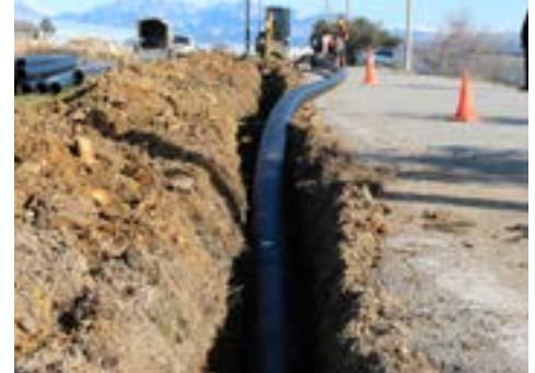
Mardin Belediyesi (Marsu) Kızıltepe İçme Suyu Yapım İşi
