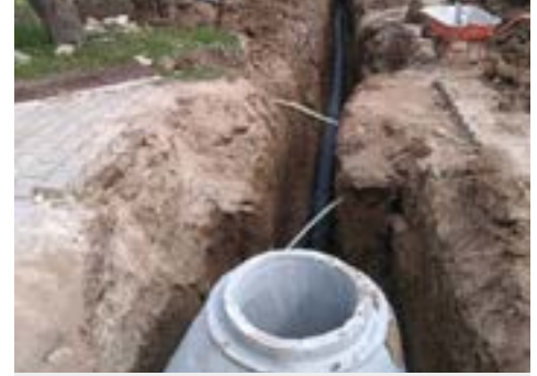
Karalar Beldesi Ek Kanalizasyon Yapım İşi
