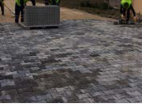
Siirt Baykan İlçesi Veysel Karani Beldesi Parke Taşı Döşeme İşi
