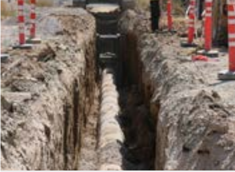
Şırnak Merkez Kanalizasyon Şebeke Yapım İşi
