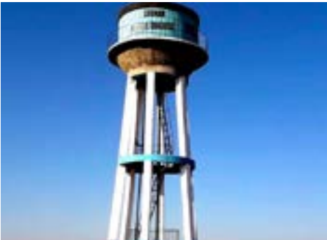
Cizre İlçesi Katran Köyü 150 SM3 Su Deposu Yapım İşi
