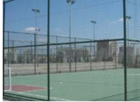
Sırtköy Belediyesi (Sportoto) Halı Saha ve Mini Basketbol Sahası Yapım İşi
