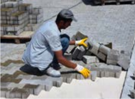
Karalar Belediyesi Beton Parke Taşı Döşeme Yapım İşi
