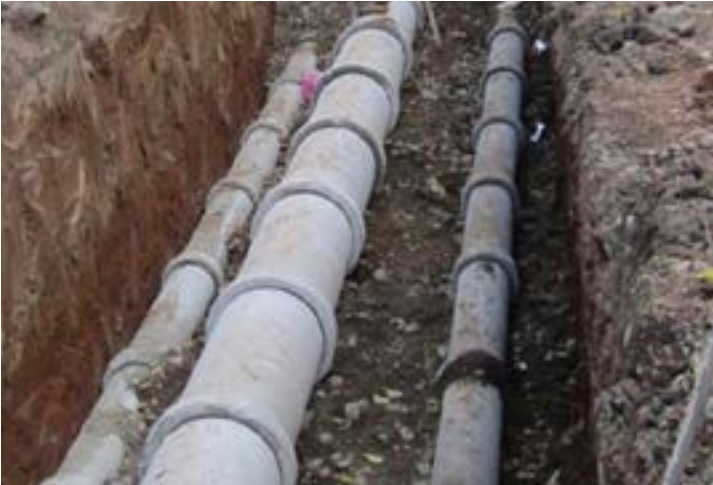
Uludere Belediyesi Şehir İçi Kanalizasyon Hatları Yapım İşi
