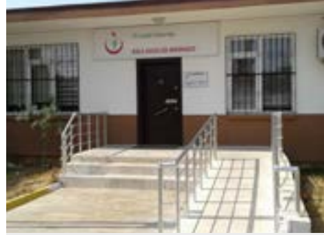
Cizre İlçesi Kurtuluş Köyü ASM Merkezi Yapım İşi
