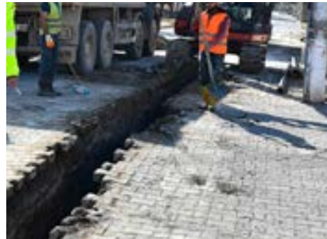
Cizre İlçe Merkezi Kanalizasyon ve İçme Suyu Altyapısı Yapım İşi
