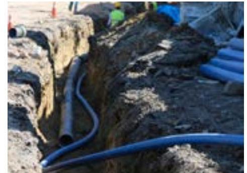
Cizre İlçesi Çavuş Köyü İçme Suyu Yapım İşi
