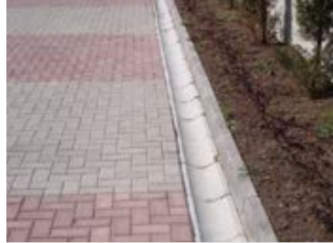
Cizre Belediyesi Parke Taşı ve Oluk Taşı Döşeme Yapım İşi
