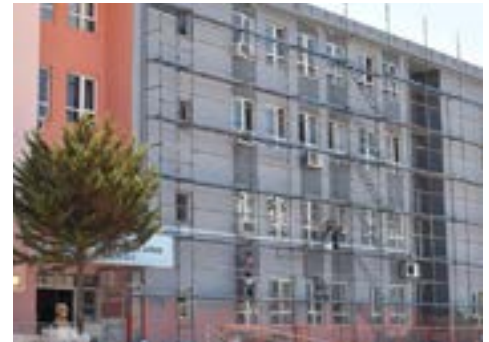
Cizre İlçe Milli Eğitim Bünyesindeki Okulların Bakım Onarım İşi
