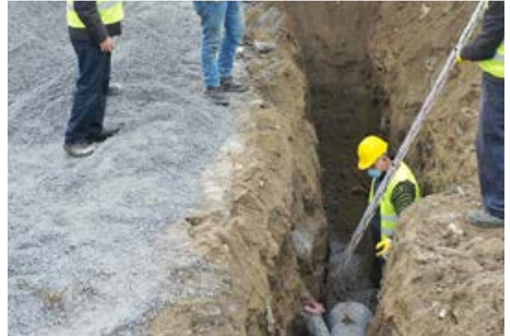
Mardin Sultan Köy İsale Hattı Yapım İşi (Marsu)
