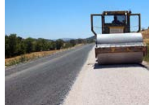
Karalar Belediyesi Yol Yapım İşi
