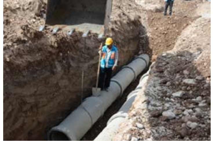
İlbank Erzincan Altınbaşak Beldesi Kanalizasyon Yapım İşi
